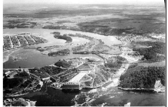
[La centrale électrique de Shawinigan vue à vol d'oiseau] © Auteur inconnu / BIBLIOTHÈQUE ET ARCHIVES Canada
